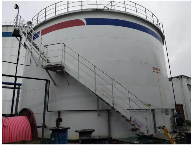
图 5 广西某发酵污水脱氮工程 UAMXR 反应器
